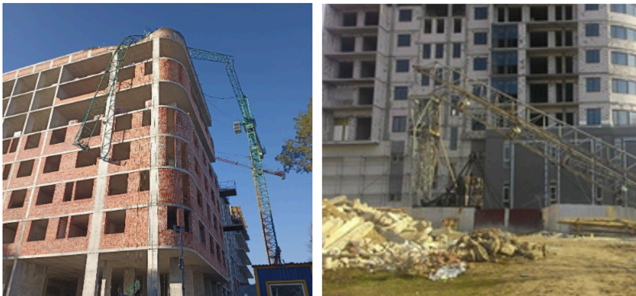
Рис. 1.1. Аварії баштових кранів, з руйнуванням: стріли (м. Львів 24.10.24) та башти (м. Рівне 16.03.16)
