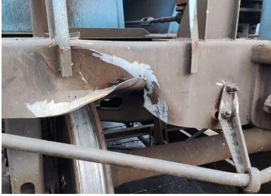
Рис.1. Пошкодження кінцевої балки
