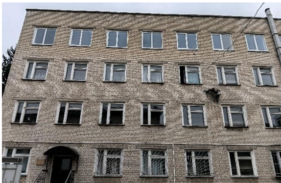
Рис. 3 - Будівля побутового корпусу депо у видимому та інфрачервоному спектрі. На четвертому поверсі вікна замінено на сучасні склопакети
