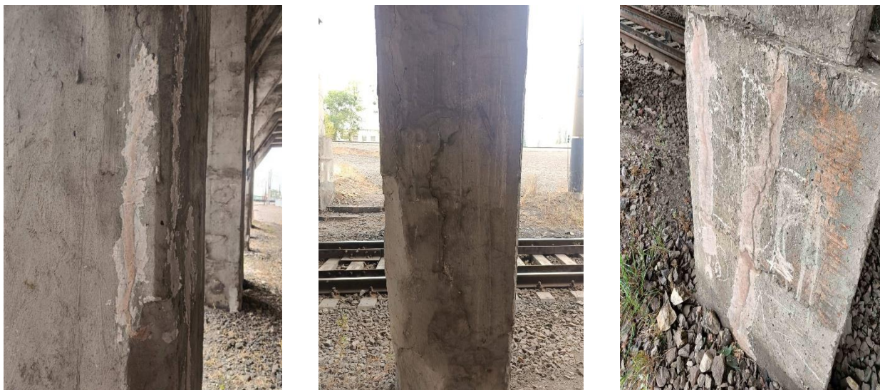
Рис. 5.3. Фото частин опори мосту після ремонту
