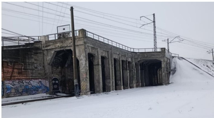
Рис. 5.2. Загальний вигляд шляхопроводу
