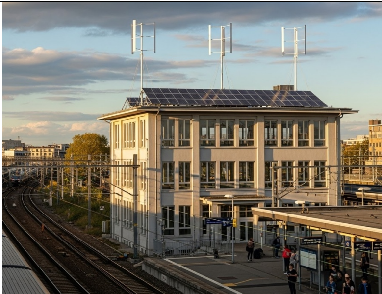
Рис. 2. Розміщення альтернативних джерел на даху поста ЕЦ
